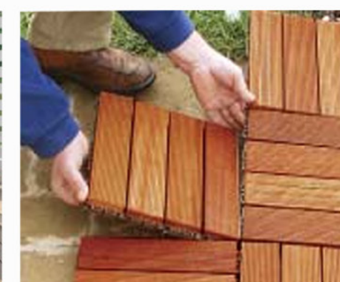
Venta e Instalación de Decks
